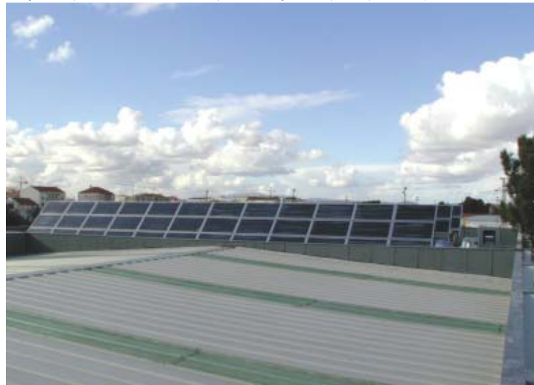
▼ Figura 15 - Aplicação de Colectores Solares de Aquecimento de Água num Pavilhão Gimnodesportivo.
