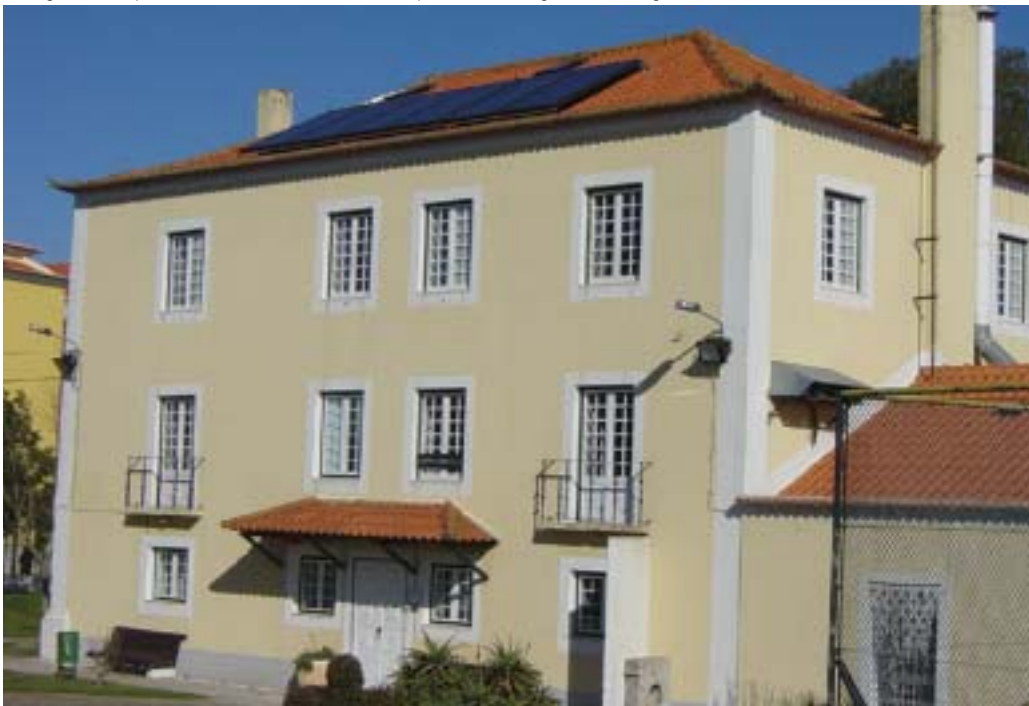
▼ Figura 13 - Aplicação de Colectores Solares de Aquecimento de Água num Albergue da Juventude.
