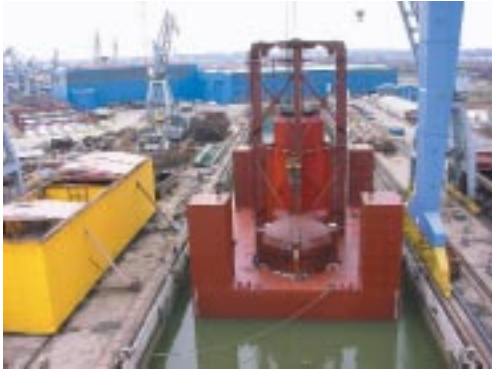
Figura 3.4.3 Perspectiva da central piloto do AWS em construção (cortesia AWS BV)
