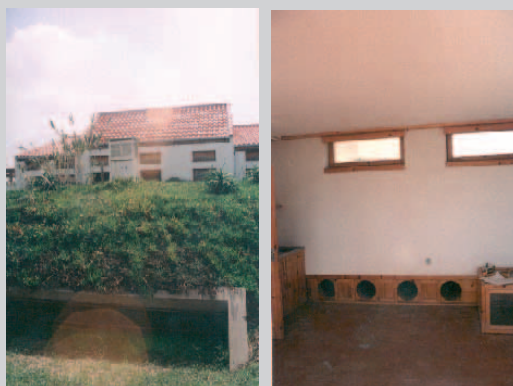
Fig. 57 – Entrada exterior e interior dos tubos enterrados
