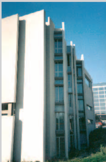
Fig. 51 – Bandeiras de ventilação - Instituto de Biologia Molecular e Celular – Porto Arq a . Fernanda Seixas, Arq a . Anne Perl De Pal
